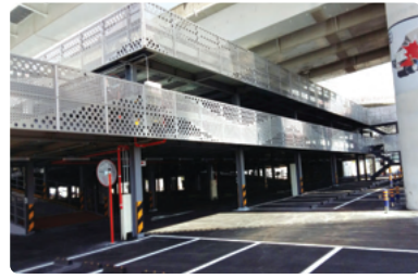
영도 남항 자주식 주차장
