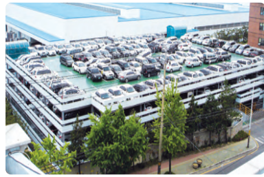
현대자동차5공장 기업부설 주차장
